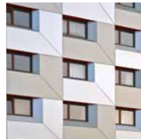
Architektengemeinschaft Zimmermann (DE) Studentenwohnheim, Dresden, (DE)
